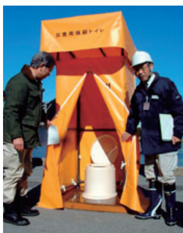
図-17.2 マンホールトイレシステムの例 出典：地震対策マニュアル 2006
