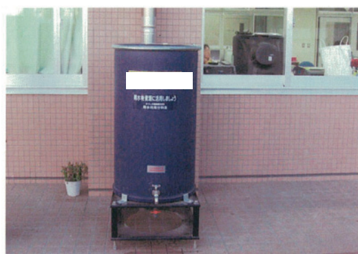
図-14.4 雨水貯留施設（タンク）
